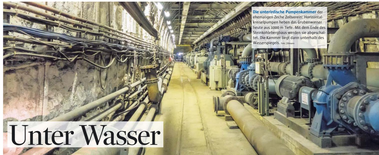
Die unterirdische Pumpenkammer der ehemaligen Zeche Zollverein: Horizontalkreiselumpen heben das Grubenwasser heute aus 1000 m Tiefe. Mit dem Ende des Steinkohlebergbaus werden sie abgeschaltet. Die Kammer liegt dann unterhalb des Wasserspiegels. Foto: Zillmann
